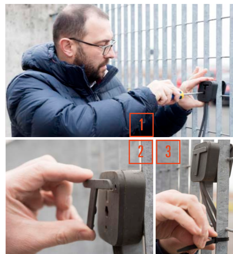
Montare il sensore sulla recinzione da proteggere con l'apposita contropiastra e serrare la vite centrale del sensore. Applicare la T a copertura del foro della vite e fissare il cavo alla recinzione con fascette.
