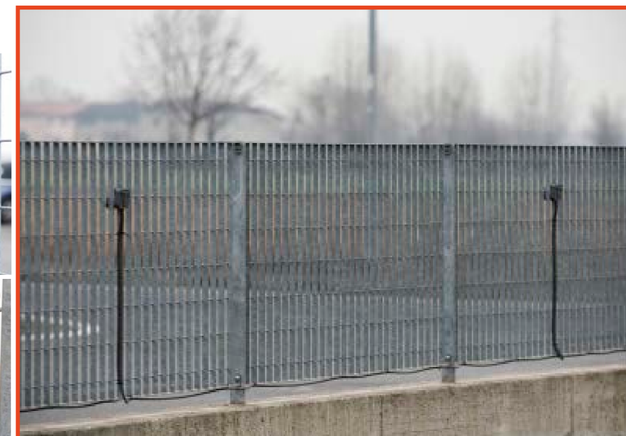
Montare il sensore sulla recinzione da proteggere con l'apposita contropiastra e serrare la vite centrale del sensore. Applicare la T a copertura del foro della vite e fissare il cavo alla recinzione con fascette.
